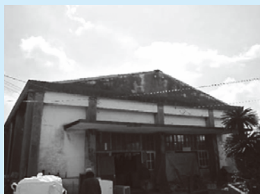
旧星原中学校武道館解体工事 1,216万円
