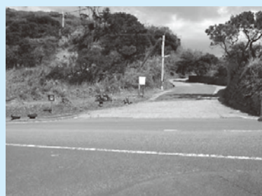
道路改良舗装事業 (梶瀨1号線他5路線) 28,023万円
