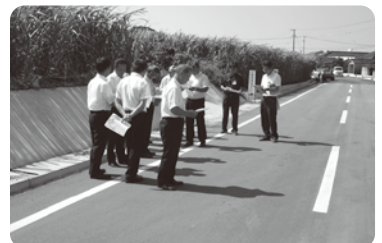
▲現場確認（伏之前線改良工事）
