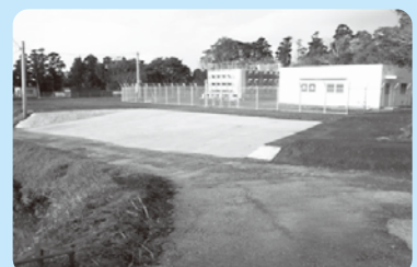
簡易水道再編推進事業（大塩屋飲料水供給施設外10件）26,631万円
