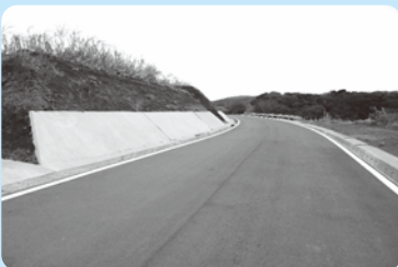
道路改良舗装事業（梶瀨線外4路線）16,540万円
