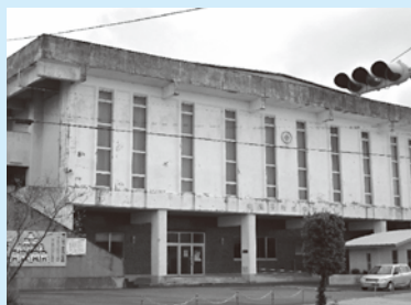
町立体育館大規模改修事業 8,662万円
