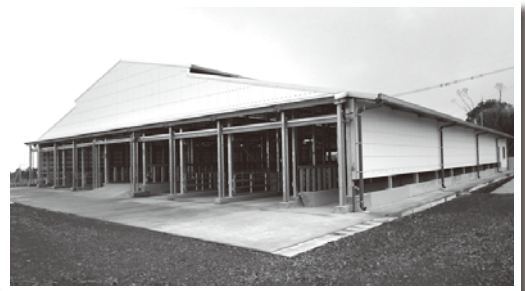
▲畜産基盤再編総合整備事業畜舎建設
