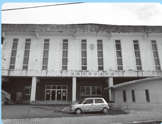
町立体育館大規模改修工事 (工事監理・屋上防水) 1,290万円
