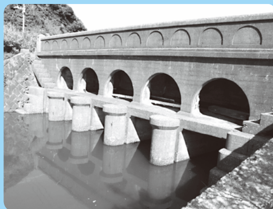
熊野水門補修調査 454万円
