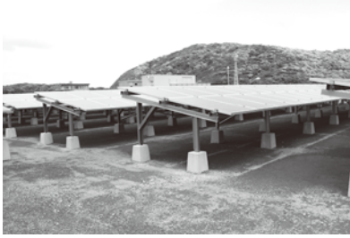
▲熊野干拓跡地太陽光発電所
