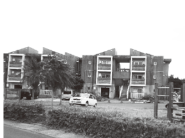
公営住宅長寿命化対策事業 (伏之前団地ほか) 9,526万円
