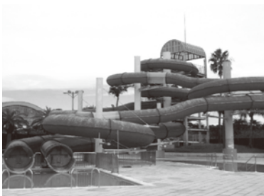
公園長寿命化対策支援事業 (スライダープール改修) 6,814万円
