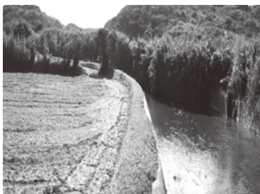
河川改修工事(阿高磯川) 2,400万円
