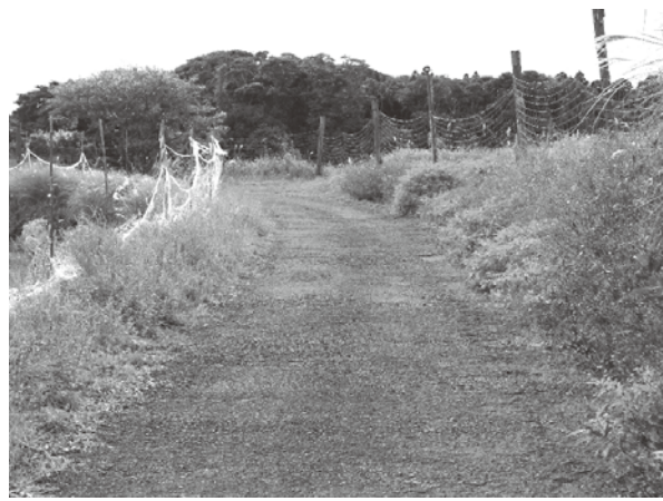
●町道維持補修工事 1,250万円 (竹之川田之頭線外4路線)
