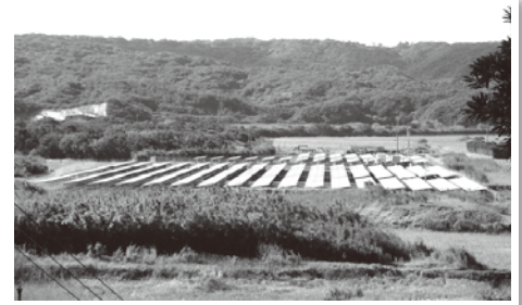
▲九州おひさま発電所
