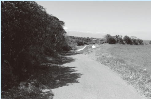
道路改良舗装事業(梶瀨1号線他) 17,252万円
