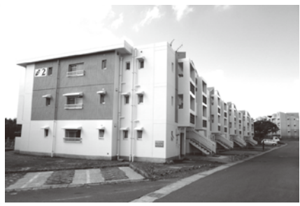
▲町営伏之前団地
