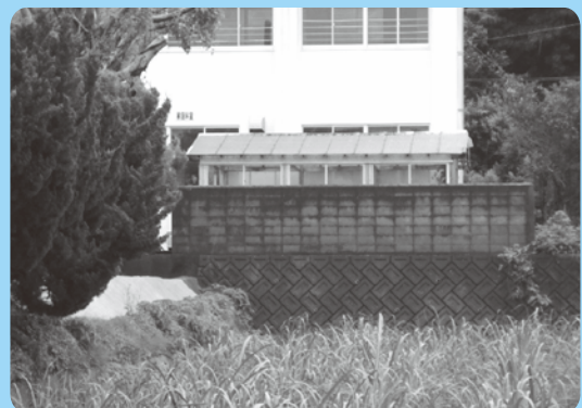
各小学校ブロック塀撤去、防護柵フェンス工事 1,060万円
