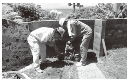
▲ブロック塀調査状況
