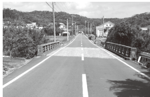
橋梁修繕事業(前田浦橋他) 5,080万円
