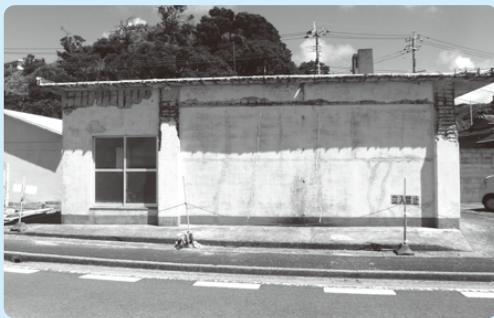
岩岡分団旧詰所解体工事 200万円
