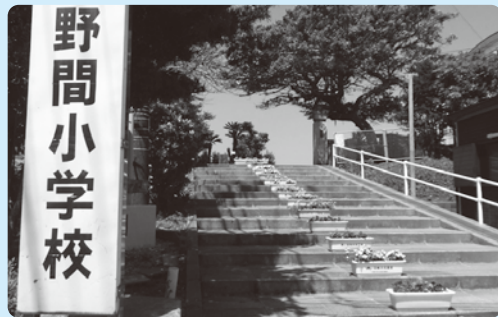
野間小学校消防設備設置工事 270万円
