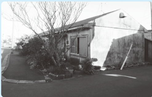
町営高校前団地解体工事 548万円
