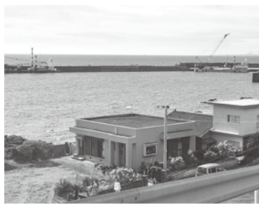
▲浜津脇港からの積み出し
