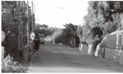
▲ 町道伏之前・原之里線の現況
