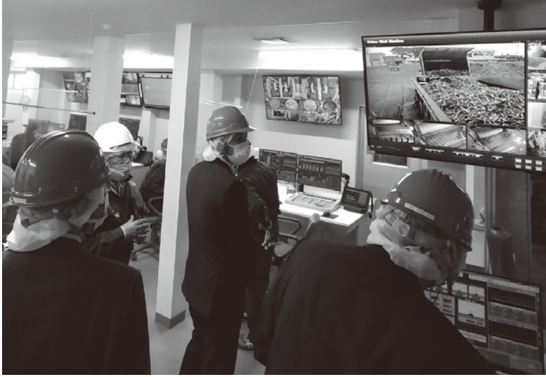
▲集中制御室の様子
