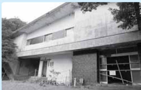
旧漁民センター解体工事 841万円
