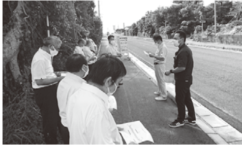
▲下馬通線歩道整備工事
