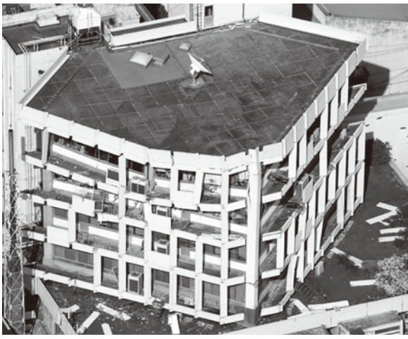
▲熊本地震で被災した庁舎
