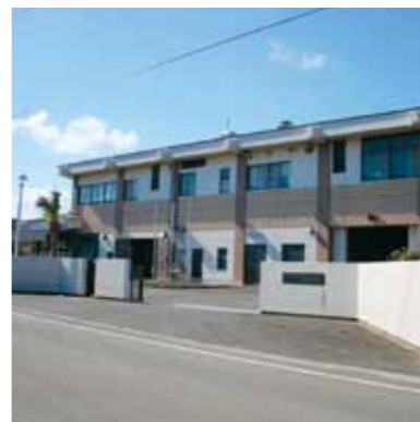
し尿処理施設(中南衛生管理組合)
