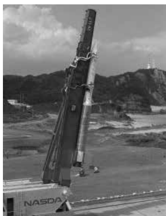
小型ロケット発射台に据え付け
