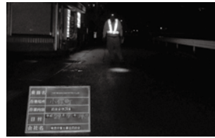
【夜間作業状況】
