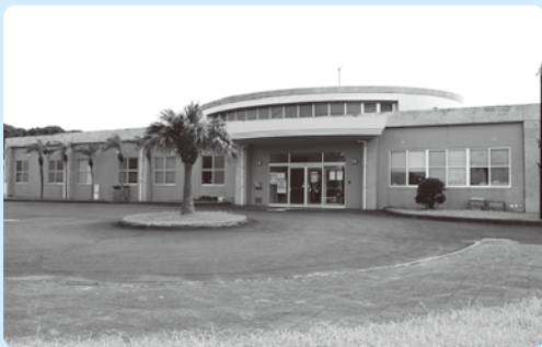
保健センター大規模改修工事 6,077万円
