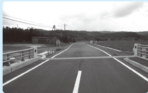
坂井熊野線道路改良舗装工事 7,000万円
