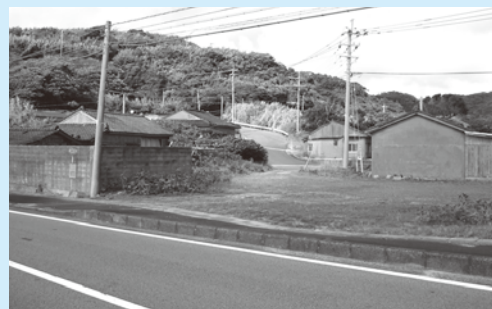
道路舗装修繕事業(交付金事業協之川橋外4件) 107,876 千円
