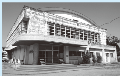
野間小体育館改修工事 70,499 千円
