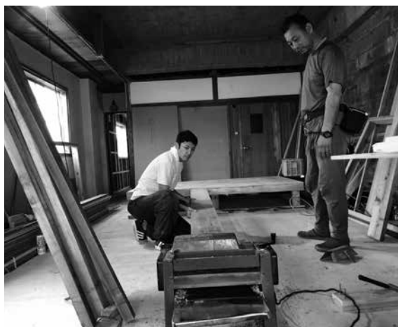
借主が空き家を修繕の様子：旭町
