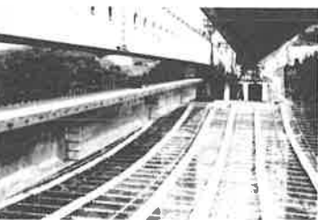
西側に一本のケタを無事渡し終えました。上は巨大な架設機械。下は防護ネット
