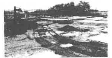
起工式後、急ピッチで進められる建築工事
