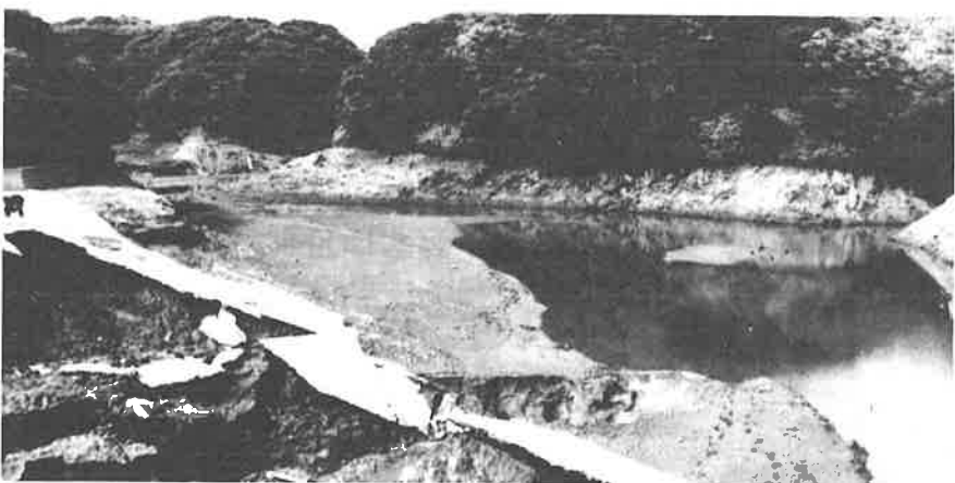
決壊した水源池のダム、10メートルの水位が一瞬にして0メートルになった
