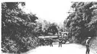
土砂崩れの復旧を急ぐ国道
