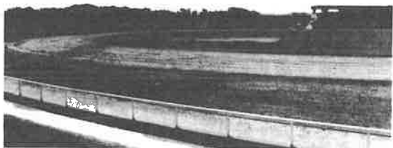
大體の里(中央運動公園)の陸上競技場も完成間近か
