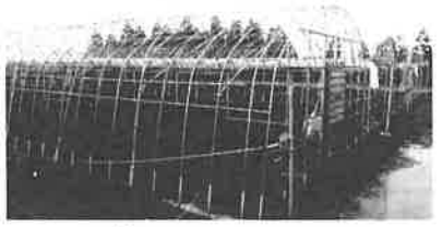
設置工事を終えビニール掛けを得つハウス
