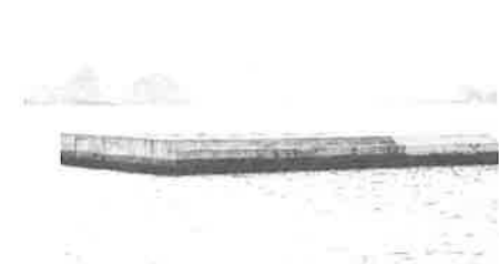
3基のケーソン設置を終えた蓄養施設
