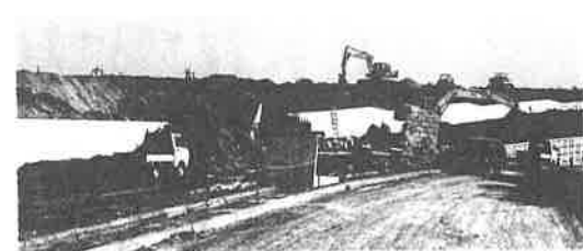
工事を急ぐ運動公園周辺
