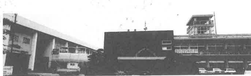
中央公民館に身障者昇降用のスロープが建設され、使いを交える庁舎
