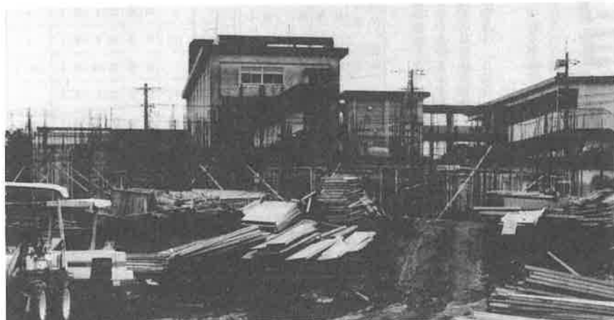
基礎工事を終えた段階の2号棟建設現場。道方は中種子高校校舎
