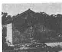
共同集荷所 (屋久津) 1棟 25.6坪 ブロック
