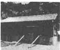
醸加工共同施設 (熊野) 1棟 30坪 附帯施設一式
