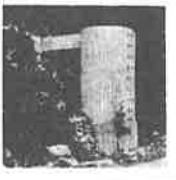
野間中、増田小 鉄筋校舎竣工
