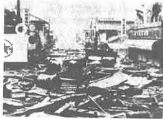
倒壊流出した商店街
