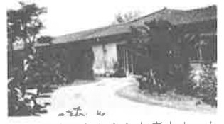
新しく建てなおされた老人ホーム
