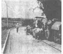
着々すすむ町道舗装
