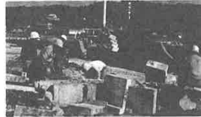
N型魚礁の積みこみ作業
