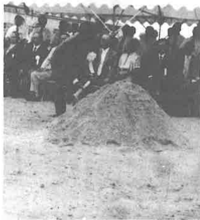
第2中種子地区の起工式、くわ入れをする町長
