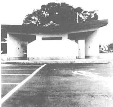
完成した公衆便所
