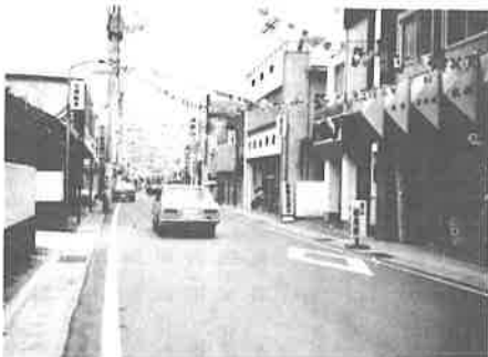
街路灯など環境整備が進められている野間商店街
