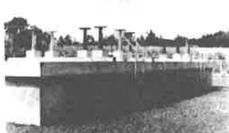
安定供給を続ける北部地区簡易水道のろ過池
