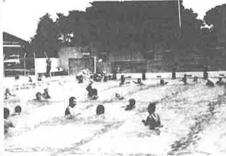
後方は倉庫、更衣室、トイレ棟
