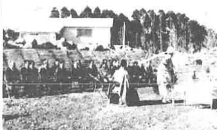
野間・池之向の建設現場で行われた起工式
