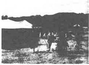
つつがない完成を祈る起工式
