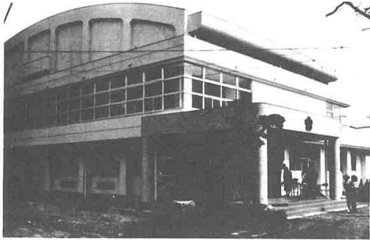
近代建築技術の粋を集めて完成
