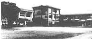
外装工事を終え、真新しくなった校舎
