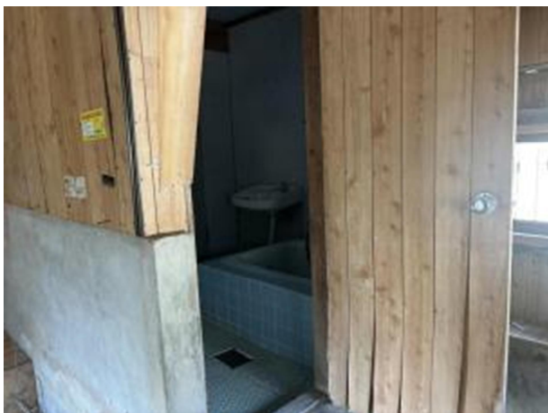
<土間～浴室入り口>
