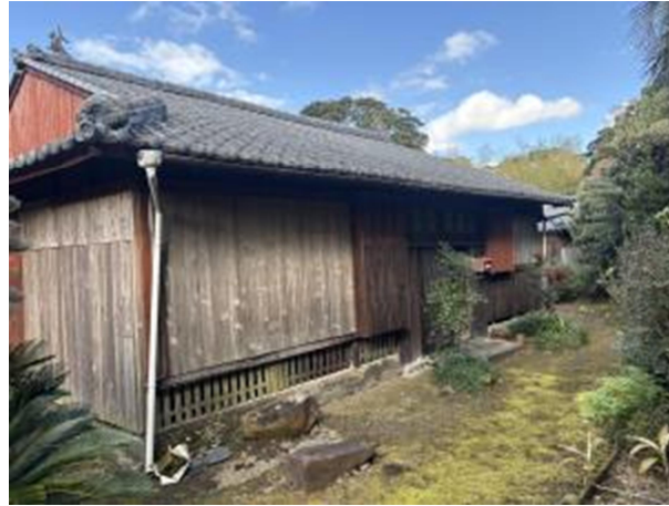
<外観(玄関付近)>
